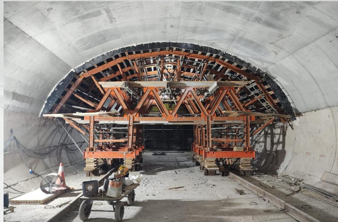
Túnel em execução (junho de 2025)
