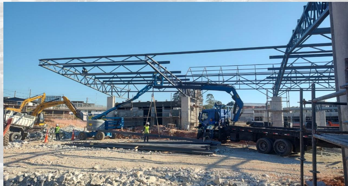
Terminal de Ônibus Varginha (julho de 2025)
